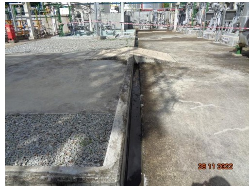
รูปที่ 3.57 คันกันล้อรอบบริเวณปั๊มสูบน้ำโพธิ์หินออกไซด์
