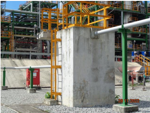
รูปที่ 3.18 Side Steam Filter Backwash Basin
