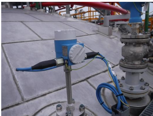
รูปที่ 3.59 อุปกรณ์วัดอุณหภูมิ และระดับของเหลวในถังเก็บโพรพิลีนออกไซด์
