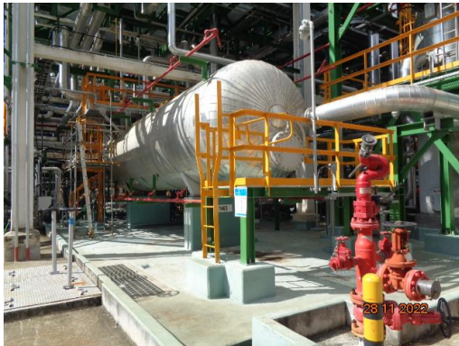
รูปที่ 3.40 ระบบน้ำฉีด (Water Spray) รอบผนังและหลังคาถังเก็บกัก (ต่อ)
