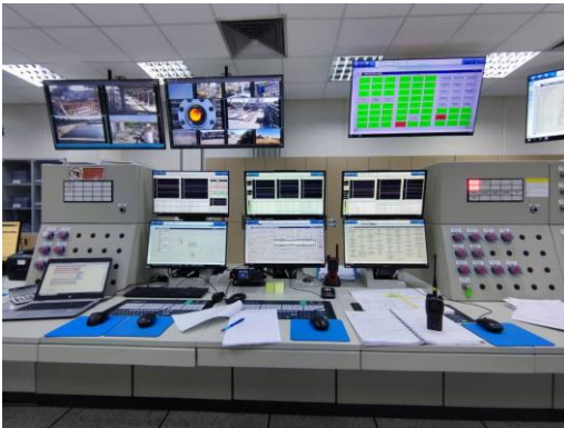
รูปที่ 3.52 ระบบ Distributed Control System (DCS)
