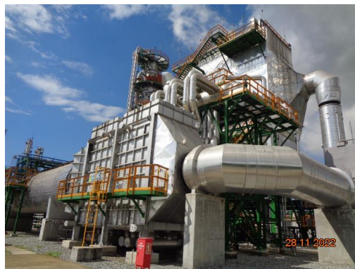
รูปที่ 3.20 Dust Removal Unit
