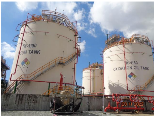
รูปที่ 3.40 ระบบน้ำฉีด (Water Spray) รอบผนังและหลังคาถังเก็บกัก
