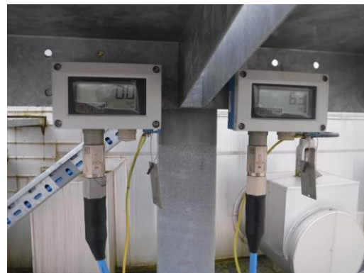
รูปที่ 3.59 อุปกรณ์วัดอุณหภูมิ และระดับของเหลวในถังเก็บโพรพิลีนออกไซด์
