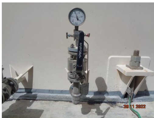
รูปที่ 3.54 Pressure / Temperature Indicator
