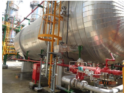
รูปที่ 3.40 ระบบน้ำฉีด (Water Spray) รอบผนังและหลังคาถังเก็บกัก (ต่อ)
