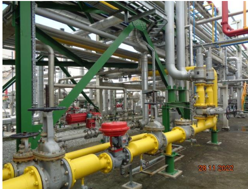
รูปที่ 3.58 อุปกรณ์ป้องกันการไหลกลับ (Back Flow Prevention Device)
