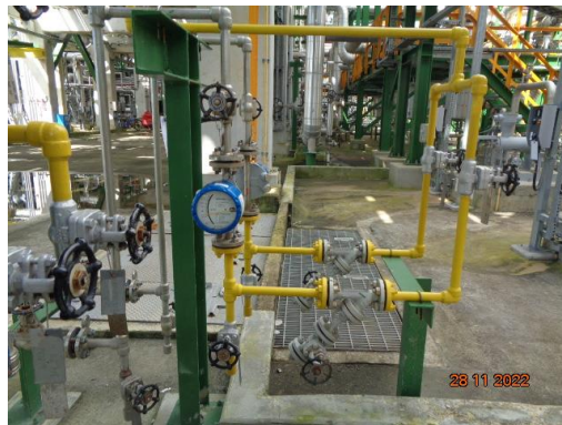
รูปที่ 3.39 ระบบก๊าซไนโตรเจนเพื่อปิดคลุม (Nitrogen Blanketing)
