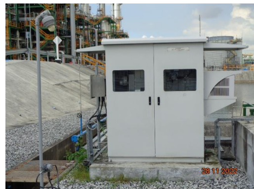
รูปที่ 3.15 TOC Online Analyzer
